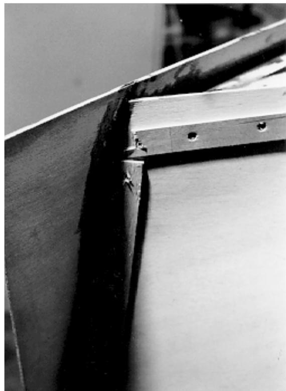
Etwa alle 10 cm wird eine Schraube gesetzt. Zu dieser Arbeit ist ein Elektroschrauber notwendig. Da die Schrauben später wieder entfernt werden, legen wir Abfallstreifen aus Sperrholz (Abkleben!) unter. Die Schraublöcher werden später mit Epoxidharz verschlossen und damit gleichzeitig verdübelt. Es muß genügend Klebstoff aufgetragen werden, da das Vollholz stark saugt und alle Fugen geschlossen sein sollen.
